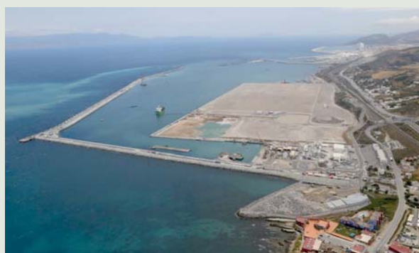
Tanger Med 2 project
